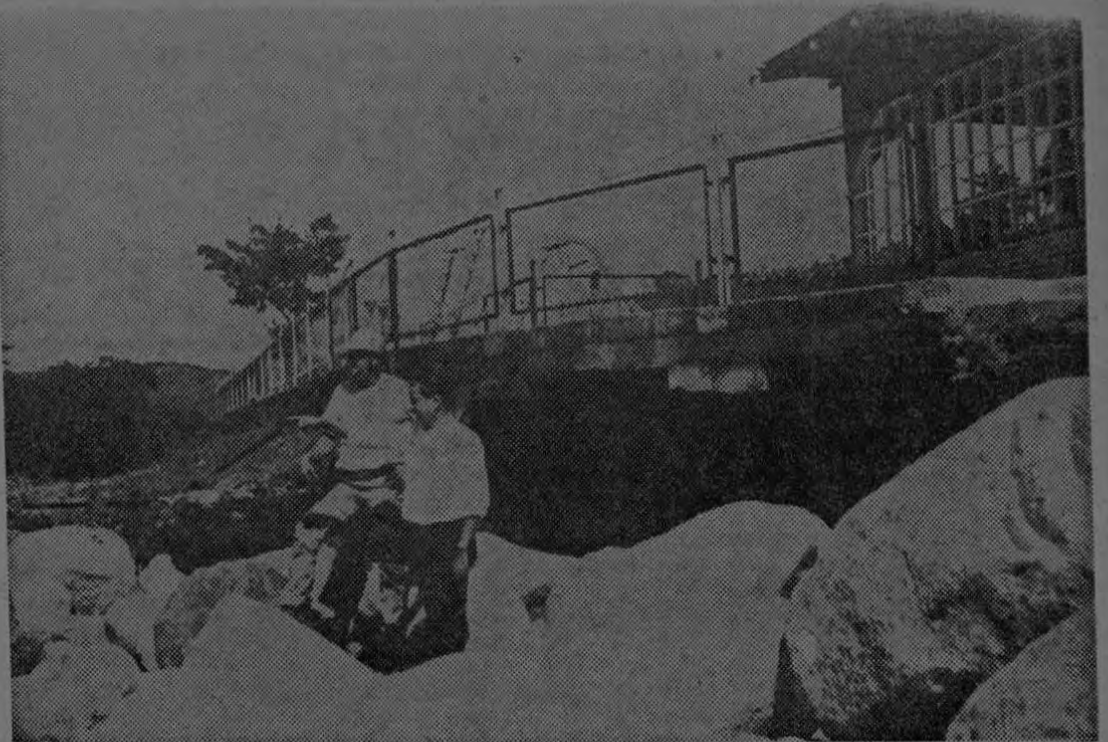
Aquí puede apreciarse la obra que se está realizando: Los tractores del Consejo están acumulando gigantescas piedras para formar una cortina que proteja a la población de Palomo de Orosí. Obsérvese los lavados que hizo el río alrededor del Motel Río, que corrió gran peligro, habiendo estado a punto de sucumbir bajo las avenidas del Reventazón.
